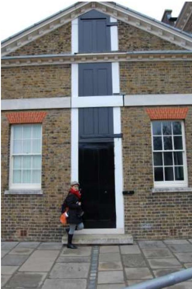
*La puerta y las ventanas que se ven en ordenación vertical en esta imagen, sirven de escotillas de observación para el antejo meridiano de Airy. En el suelo se ve la línea que determina el meridiano cero.*
